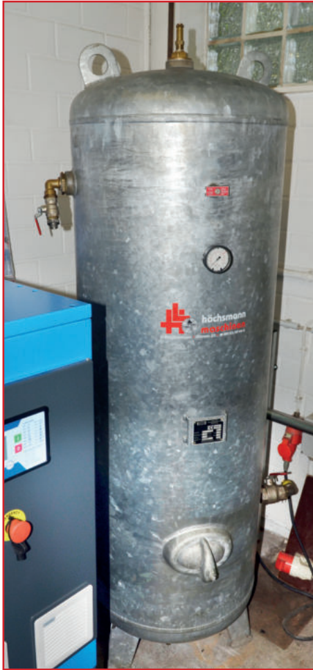
OKS Druckluft Kessel 500, Baujahr 1998, CE Zeichen, max. 11 bar, 500 Liter Fassungsvermögen, komplett mit Kugelhähnen, Sicherheitsventil und Manometer, guter Zustand, Bild links
